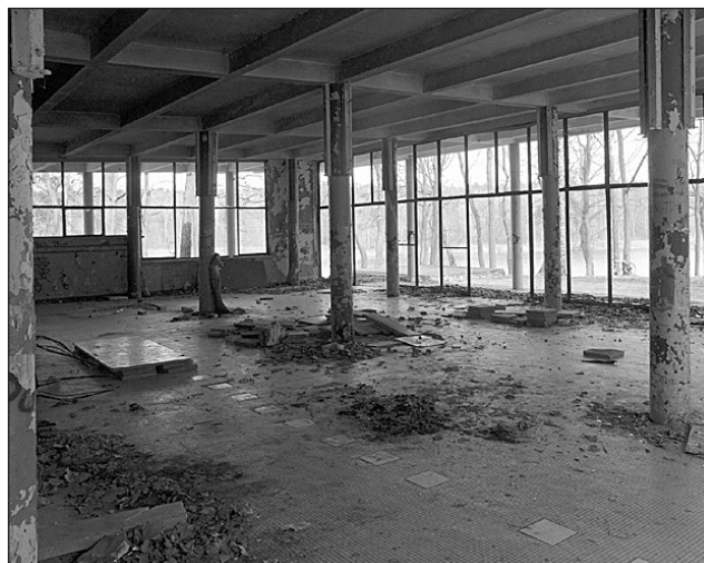
Pozostałości po kawiarni
