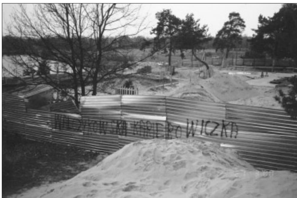
Teren budowy ogrodzony płotem (podpisanym przez inwestorów), zima 2000 r.
